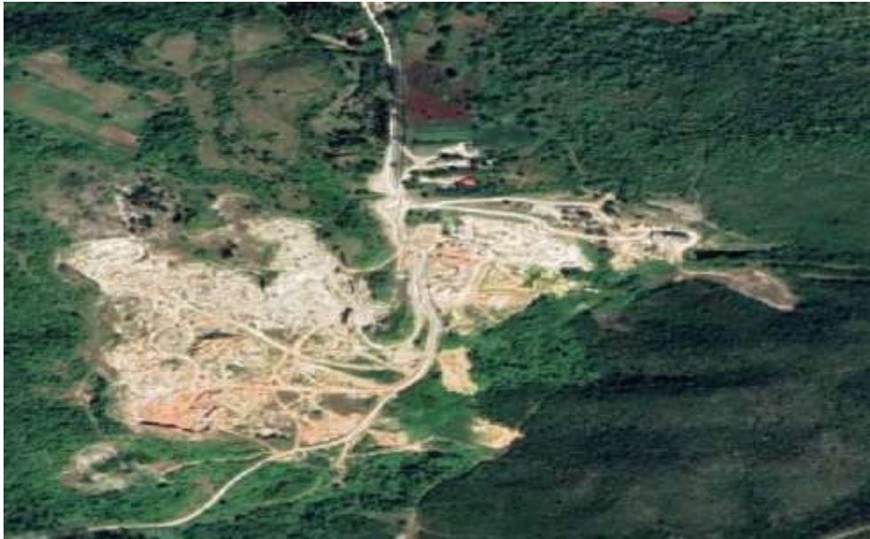
Fig.2.5 Vista satélite a una altura de 1km
