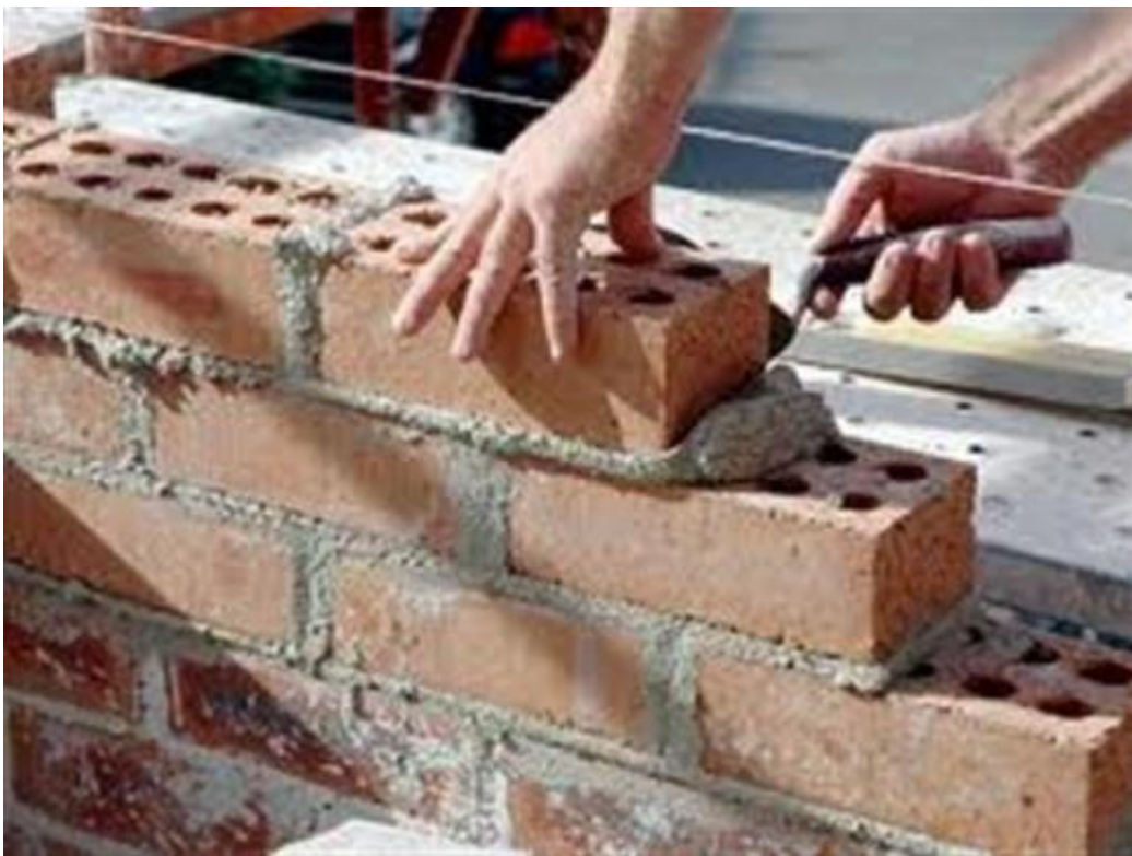
Figura – 5: Albañilería de muro de ladrillo simple.
