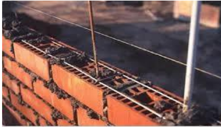
Figura – 6: Albañilería de muro de ladrillo armado.
