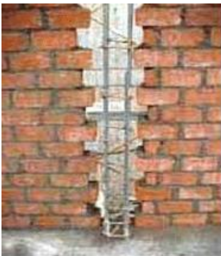
Figura – 7: Albañilería de muro reforzado o confinado
