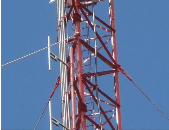
Figura 2.2 Sección del fuste de la torre. Fuente: archivos de ETECSA
