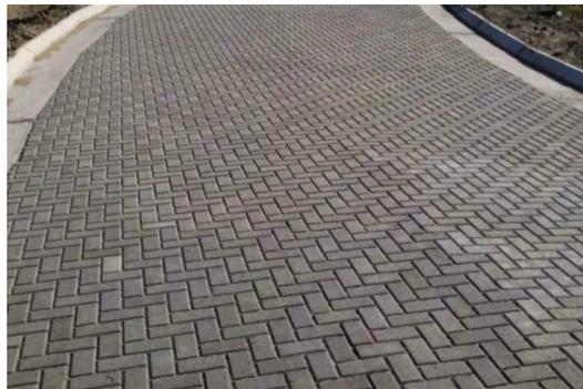
Figura 1.5 Pavimento articulado. Fuente: <https://www.ingecivil.net>
