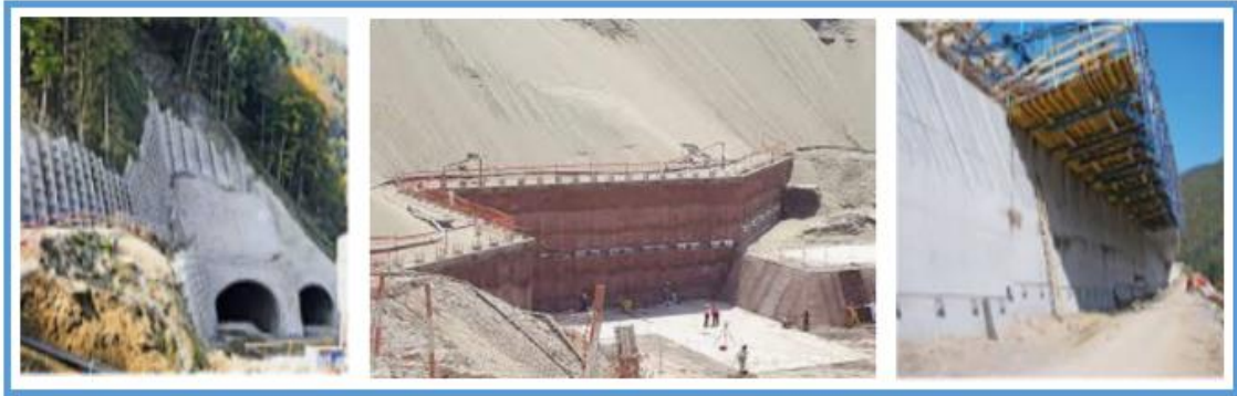
Figura 2.21 Suelos reforzados mediante el uso de anclajes
