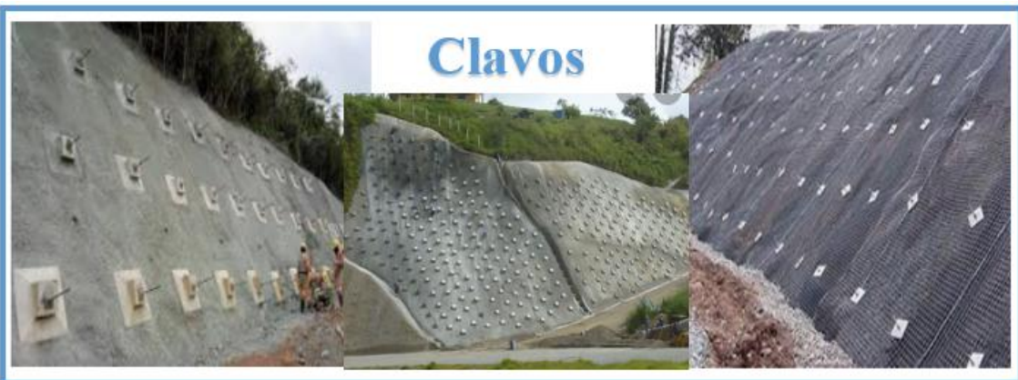
Figura 2.23 Suelos reforzados con el uso clavos
