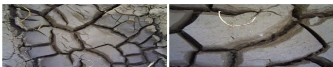
Foto 1.4 Suelo feozem háplico en estado natural, presencia de agrietamientos. 16
