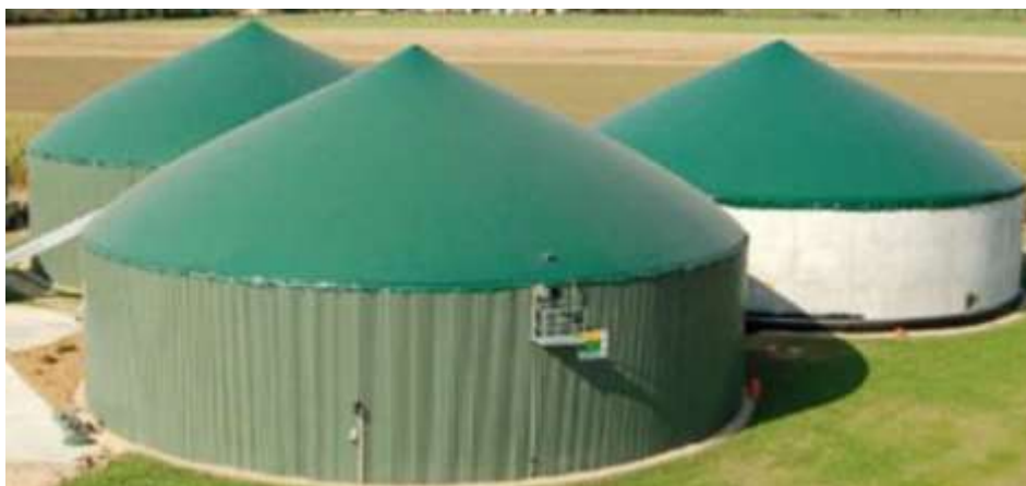
Figura 1.11. Reactores de Mezcla Completa a escala industrial. Fuente: Servicios Manufactureros Alcoholes Industriales.
