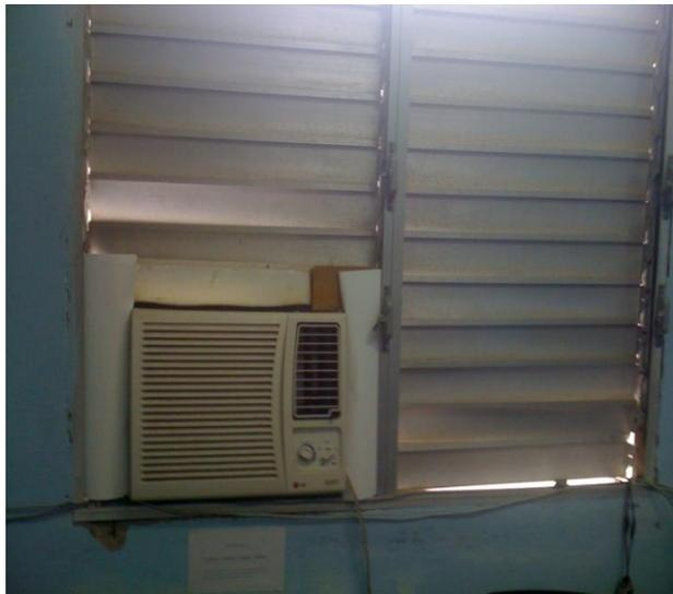
Figura 2.6 Muestra de infiltración a través de ventanas.
