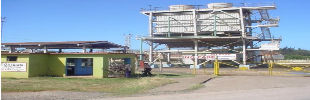
Figura 12 Obras auxiliares de funcionamiento
