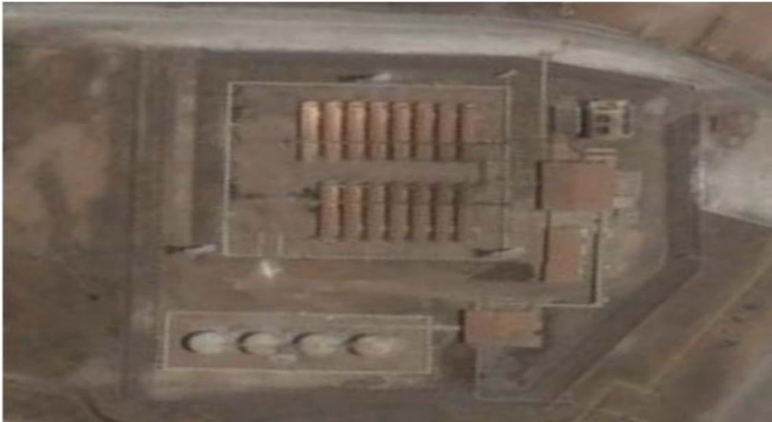
Figura 9 Vista aérea de la Base de Amoniaco del puerto de Moa.
