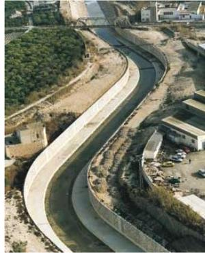
Figura 21. Encauzamiento de un río mediante un muro de contención.
