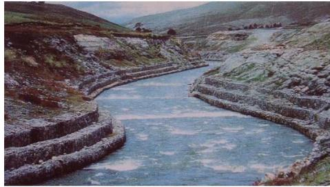
Figura 17. Muro de gaviones: Son estructuras altamente permeables, lo que impide que se generen presiones hidrostáticas (Belandria Torres, 2008).
