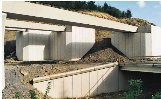
Figura 20. Estribos de un puente de muros de contención.
