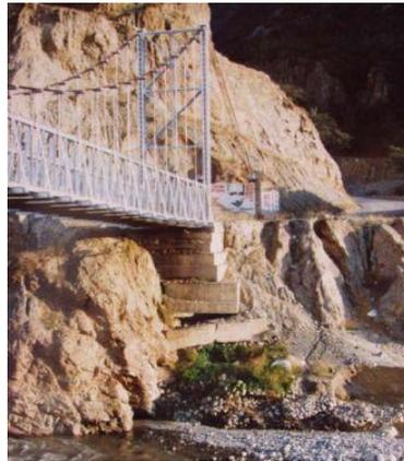
Figura 18. Muro de gaviones revestidos: Pierden flexibilidad y son sensibles a los asentamientos. (Belandria Torres, 2008).
