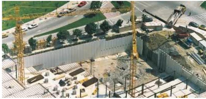
Figura 19. Muro de sótano en construcción.
