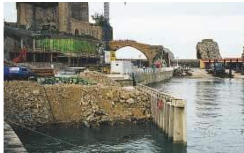
Figura 22. Muro de contención en obra marítima.
