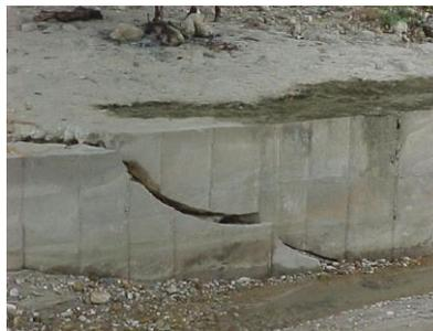
Figura 16. Muro de hormigón ciclópeo: Son sensibles a los asentamientos. Se deforman sin perder funcionalidad (Flexibilidad) (Belandria Torres, 2008).
