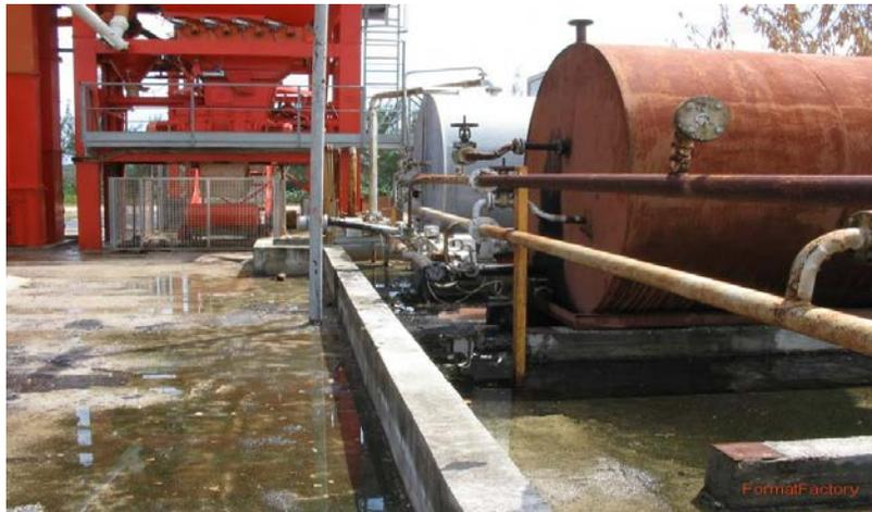
Figura 2.15 Área de calentamiento y almacenamiento del betún asfáltico.
