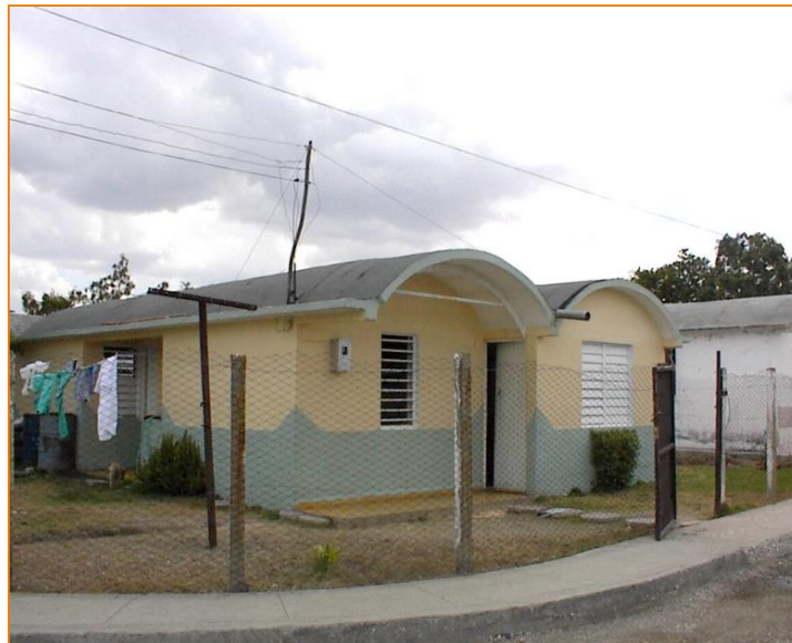
Foto 1. Vivienda con cubierta de bóveda de ladrillo
