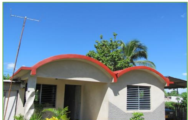
Foto 12: Vivienda con cubierta de bóveda de ladrillo
