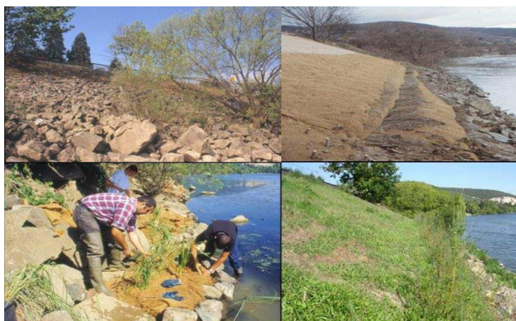
Figura 3 Revegetalización del enrocado rip-rap en el río La Saone Fuente: Quintero, 2009
