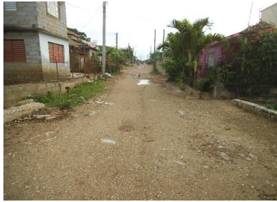
Figura 18 Calle 30 Fuente: Elaboración propia
