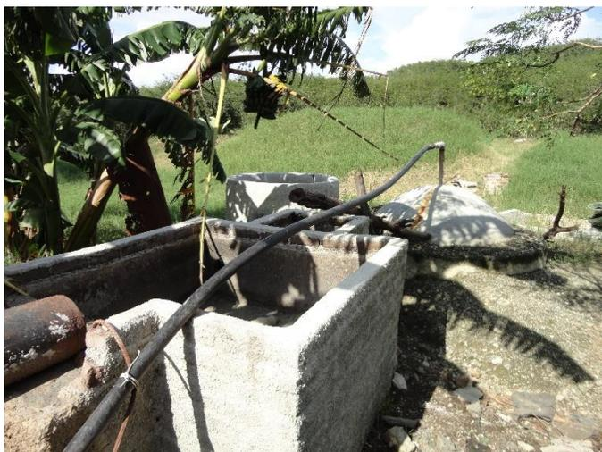
Foto 10 Tanque de almacenamiento del efluente, biodigestor, tanque de compensación y tubo de salida del biogás.
