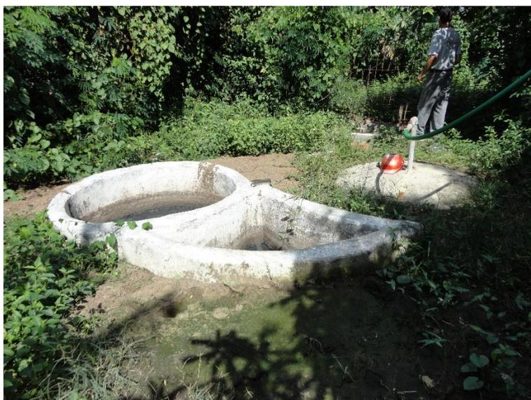
Foto 9 Biodigestor, tanque de compensación y tanque de almacenamiento del efluente.
