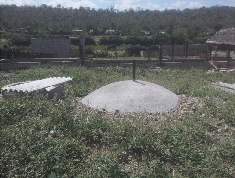
Foto 8 Biodigestor y tanque de compensación.
