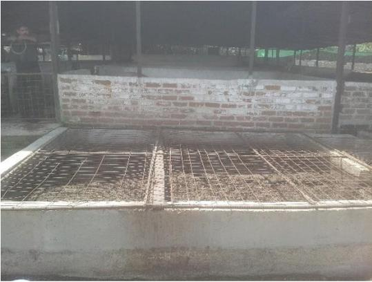
Foto 2 Depósito de almacenamiento del efluente
