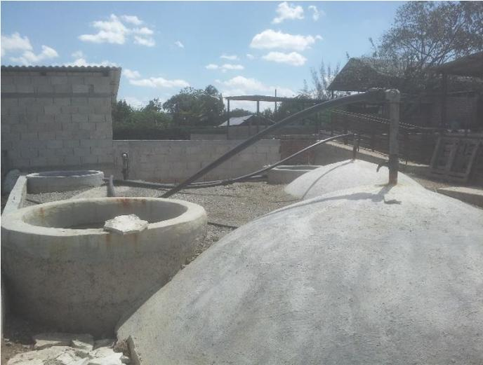
Foto 6 Biodigestores, tanques de compensación y tuberías de salida de biogás.
