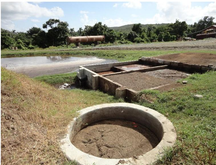
Foto 7 Tanque prefiltro, plato de secado, caja alimentadora y laguna de oxidación.
