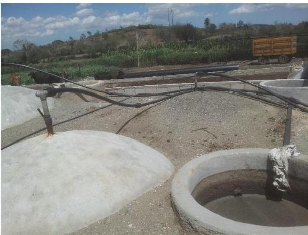
Foto 3 Biodigestores, tanques de compensación y tubos de salida del biogás.
