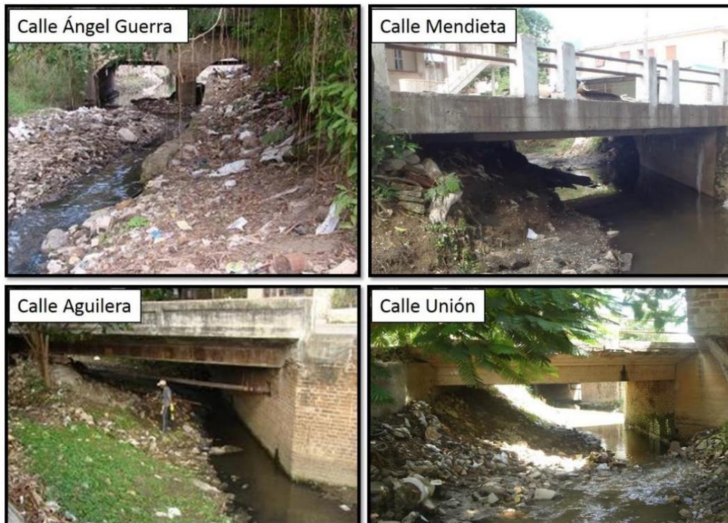
**Figura 2.3.** Secciones de los puentes reducidas y obstruidas.
