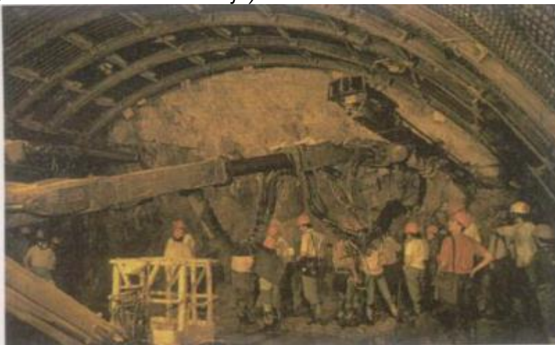
Ilustración 3 (Excavación mediante martillo hidráulico y sostenimiento con cerchas y chapa Bernolt, foto González de Vallejo)
