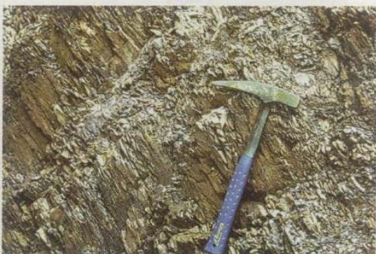
Cuarcitas ordovícicas. Calidad muy mala. Macizo muy alterado y brechificado.
