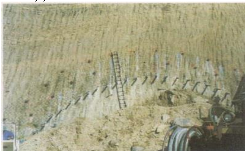
Ilustración 6 (Refuerzo del talud frontal de emboquille de un túnel. Paraguas de micropilotes, bulones y mallazo; en fase posterior el talud sería cubierto con gunita; foto González de Vallejo)
