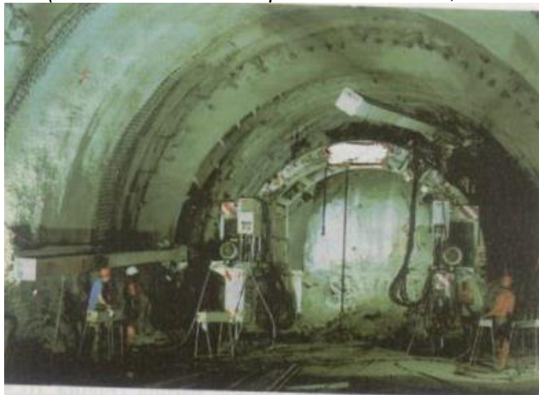
Ilustración 10 (Excavación mediante precorte mecánico, cortesía de Rodio)
