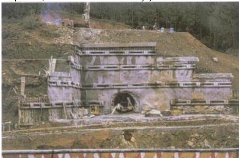
Ilustración 8 (Método tradicional de Madrid, cortesía Melis y Trabada, 2000)
