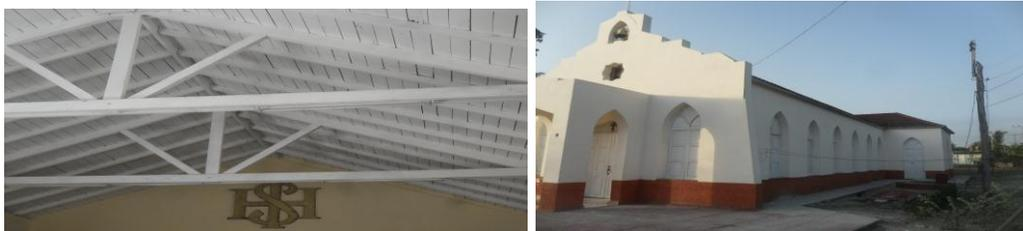
**Figura2.12.2: Cercha de madera como solución horizontal y vista lateral de la iglesia.
