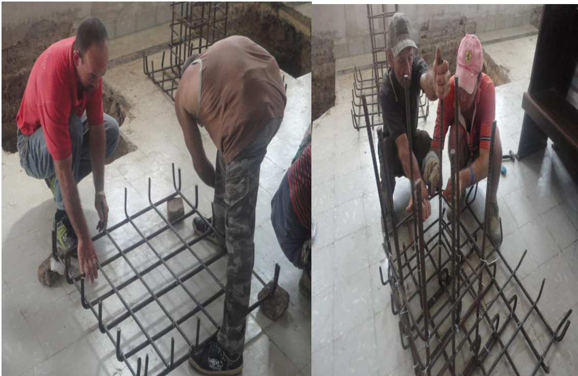
Figura B.3: Imágenes de la construcción de la armadura de acero para el cimiento.
