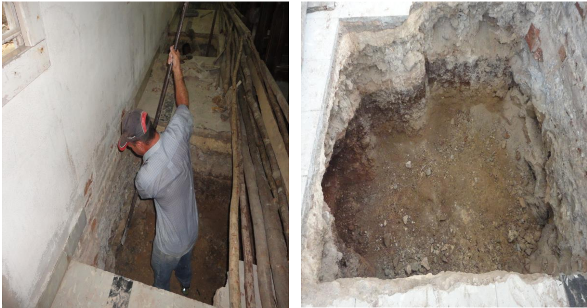
Figura B.2: Imágenes de la construcción del cimiento.
