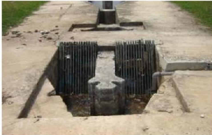
Figura – 6: Cámara de rejas de dos secciones planta María del Carmen en ciudad Habana
