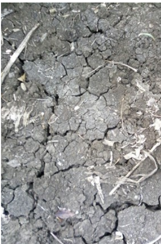
Anexo 3 Capa superficial endurecida y contraída, por la presencia de arcilla montmorillonica.
