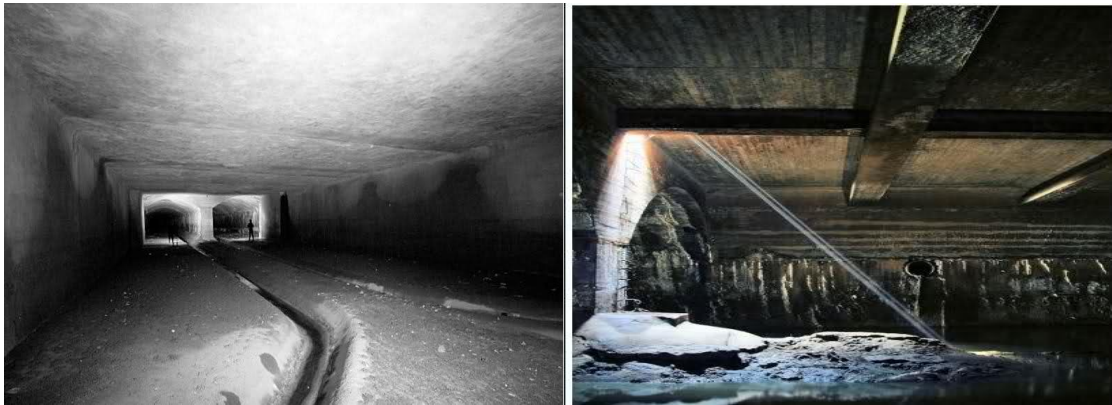
Figura - 9: Túnel de Bruselas.
