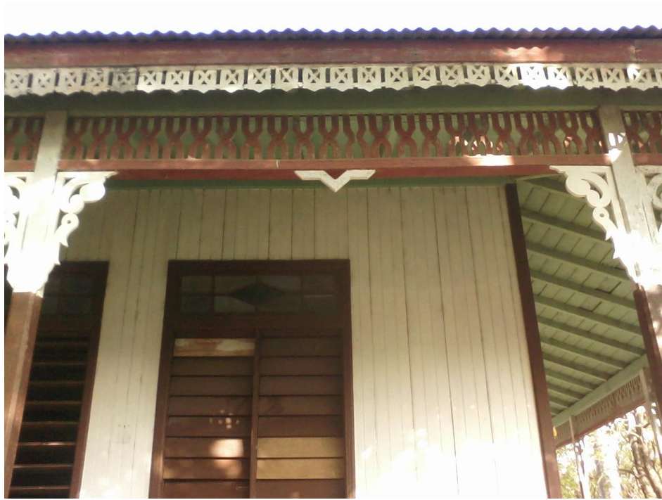
Anexo 23. Ejemplo de elemento de madera recortada (entredós). Archivo personal de la autora.
