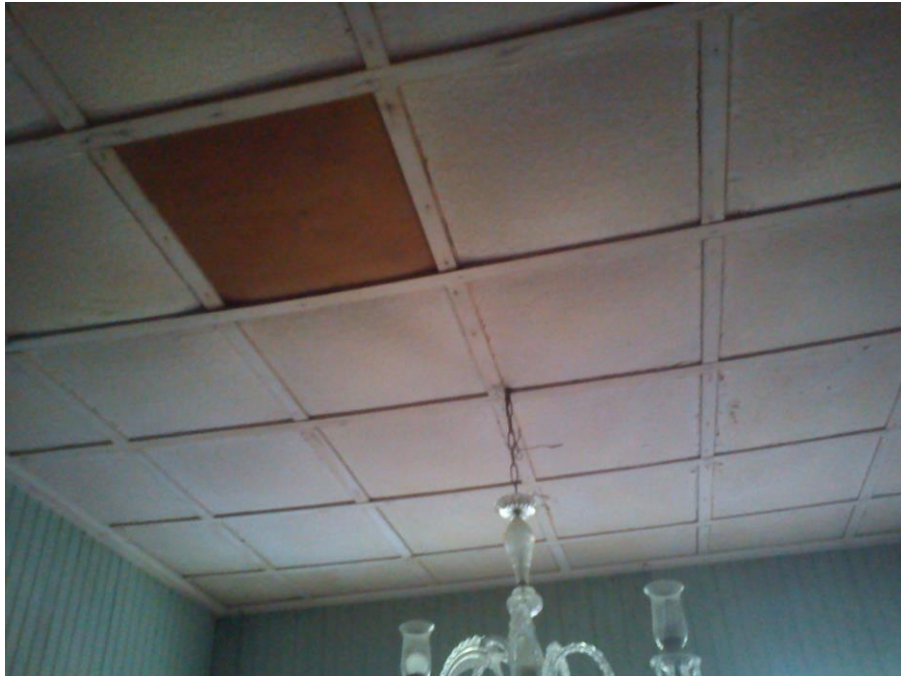
Anexo 19. Ejemplo de vivienda con falso techo. Archivo personal de la autora.
