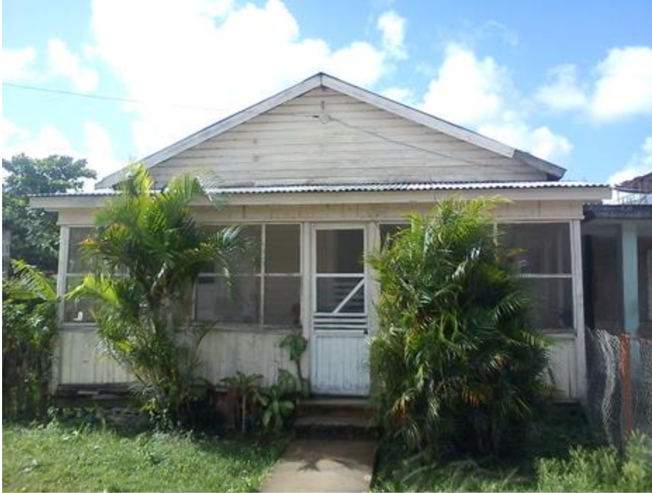
Anexo 12. Ejemplo de corredor cerrado con tela metálica. Archivo personal de la autora.
