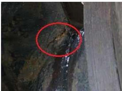
Fig. 2.6. Grieta en la zona de unión de las planchas con el núcleo del soporte
