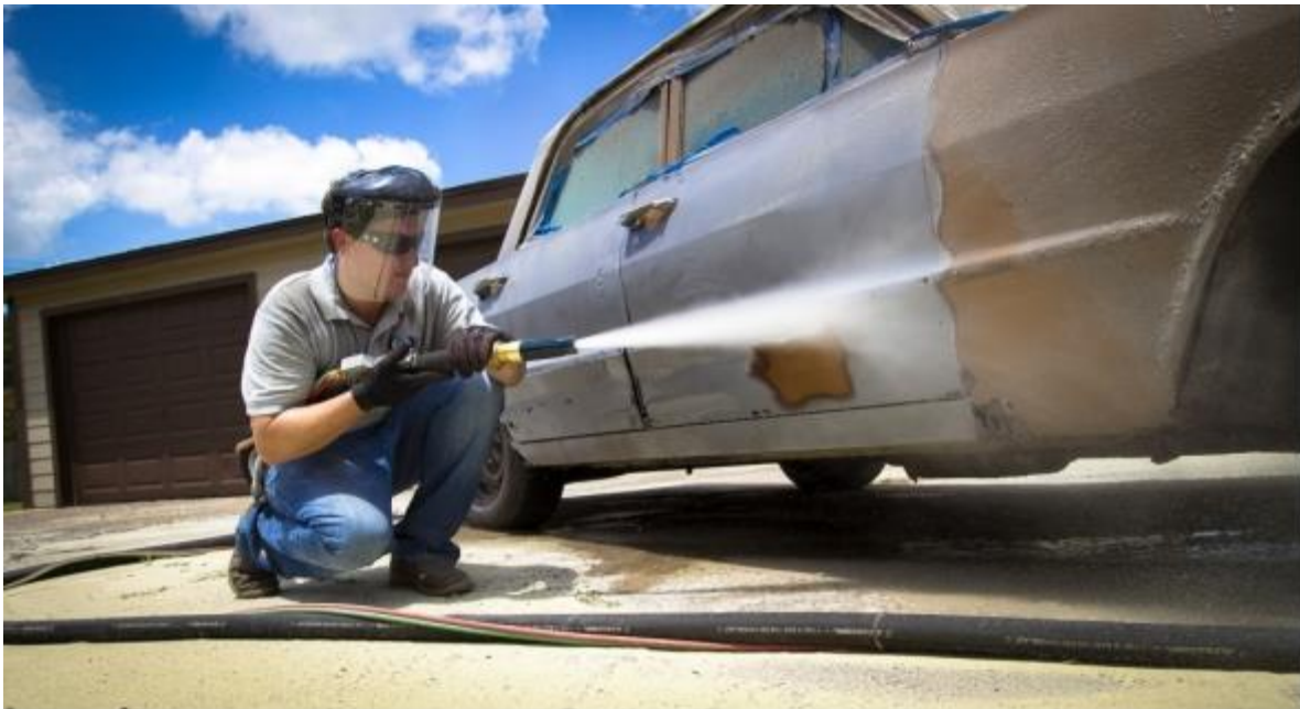
Fig. 1.2 Limpieza por sandblasting
