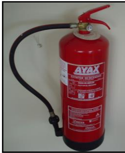
Figura 3: Extintor contra incendio ABC.
