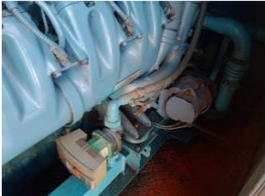
Figura 2.12 Circuito de precalentamiento del motor
