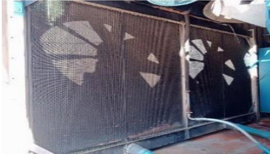
Figura 2.7 Radiador de refrigerante del circuito de alta temperatura
