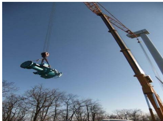
Figura 3. Maniobra de cambio de multiplicadora en aerogenerador.
