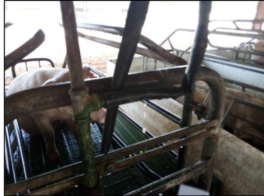
Figura 3. Tuberías en mal estado y sin llaves para el cierre.
