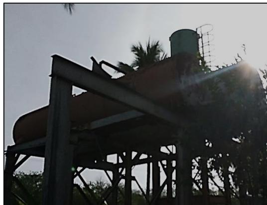
Figura 2. Pozo con electrobomba y Tanques elevados para depósito de agua.
