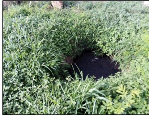
Figura 4. Registros de evacuación en mal estado técnico.
