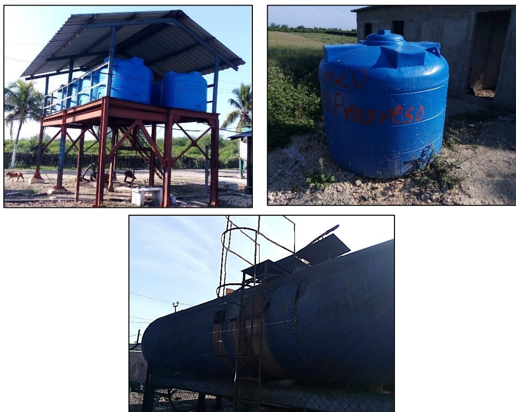
Figura 2. Tanques elevados y de agua potable, tanque de hierro para la higienización de las naves.
