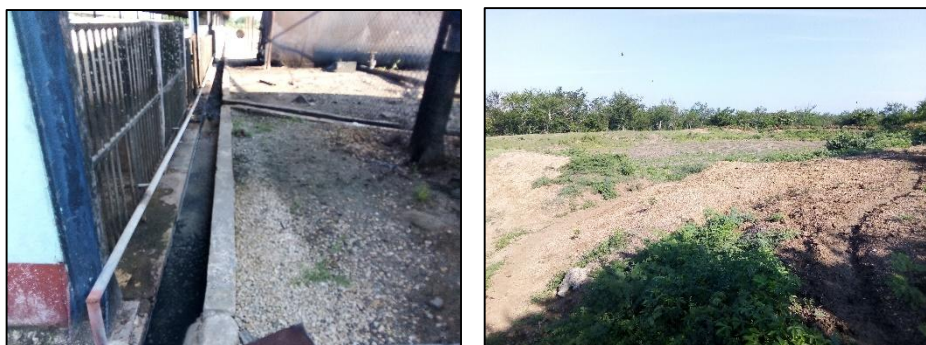
Figura 4. Canaletas de evacuación de residuales y laguna estabilizadora número tres.
