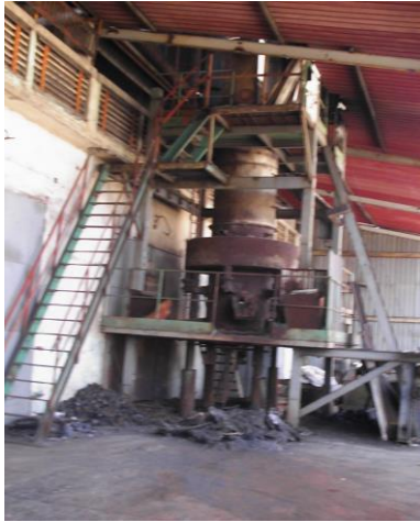
Fig. 2.1 Horno de cubilote HC – 720 mm Taller de Fundición de la UEB “Héroes del 26 de Julio” Holguín
