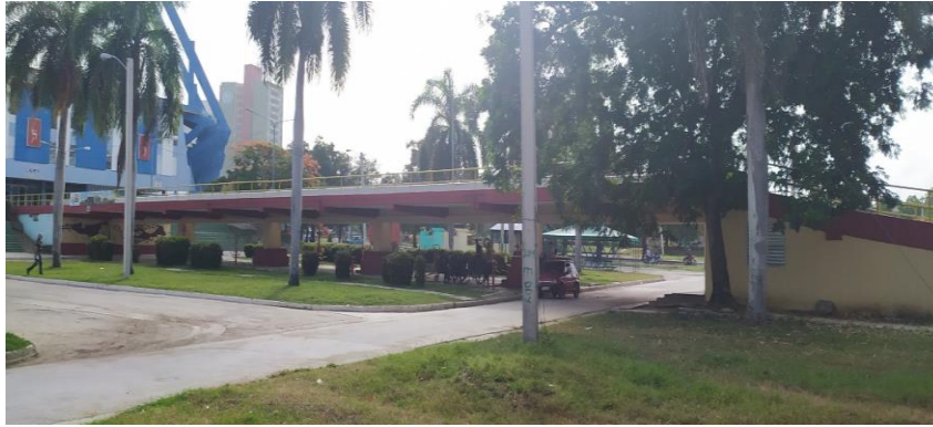
Figura 1.10 Puente peatonal del estadio Calixto García. Fuente: elaboración propia (2020).
