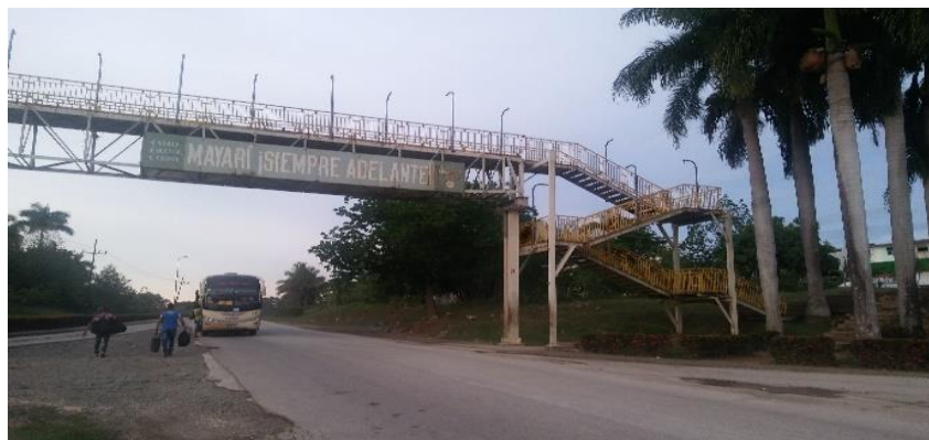
Figura 1.11 Puente peatonal del municipio Mayarí provincia Holguín. Fuente: (Romero 2019).
