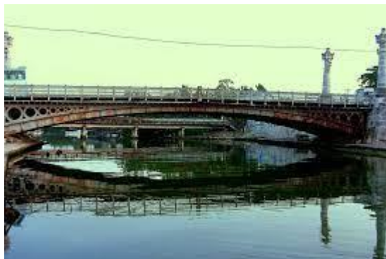
Figura 1.7 Puente peatonal sobre el Río Yumurí. Fuente: TV Yumurí (2015)
