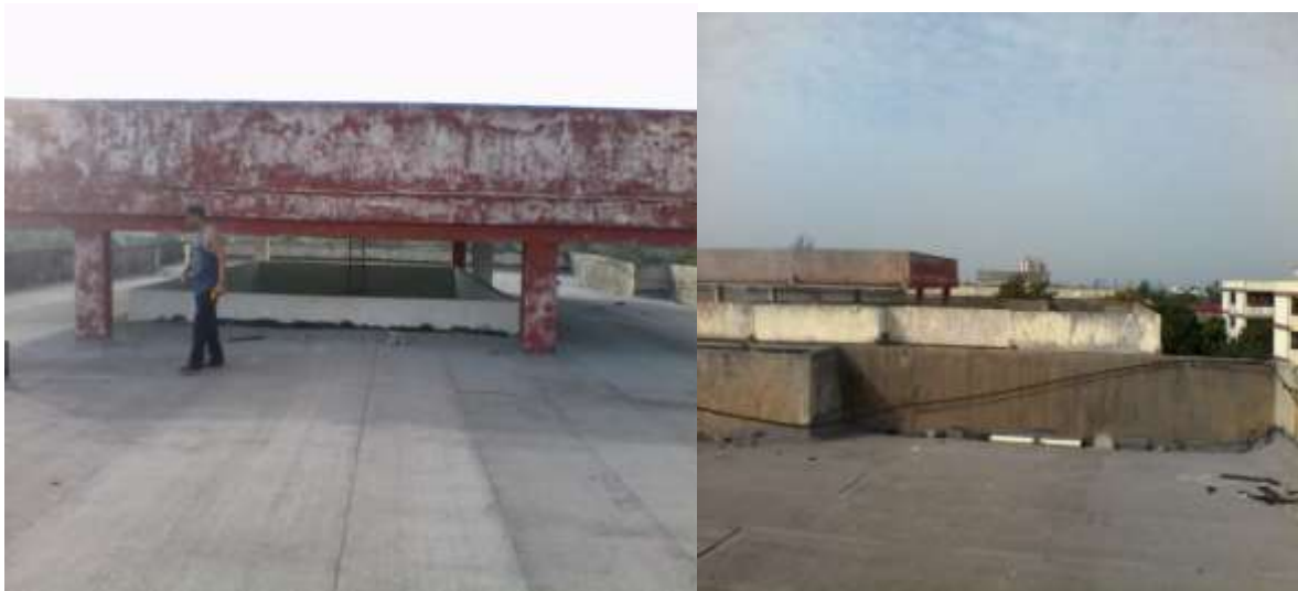
Figura No. 18: Imagen azotea edificio residencial
