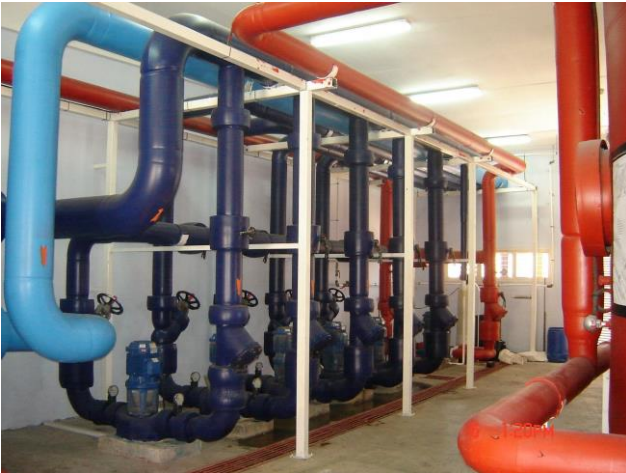
Figura A5.1. Circuito Primario de Agua Fría
