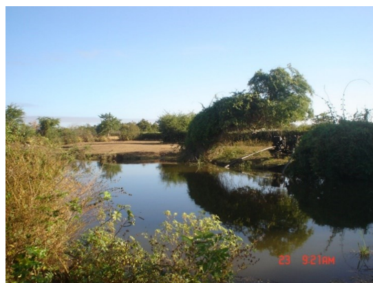
Fuente: Proyecto de Extensión Agraria Figura 14 Derivadora de la presa Las Lajas, utilizada para el riego.
