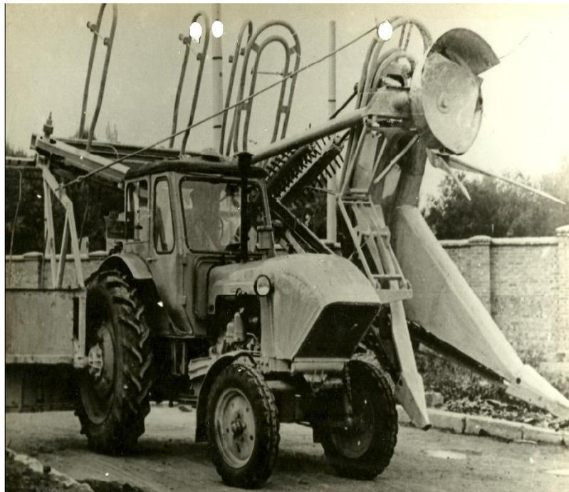
Figura 1.12. Cortadora de caña dotada de cortacogollo por impacto. Fuente: Max (Archivo personal)
