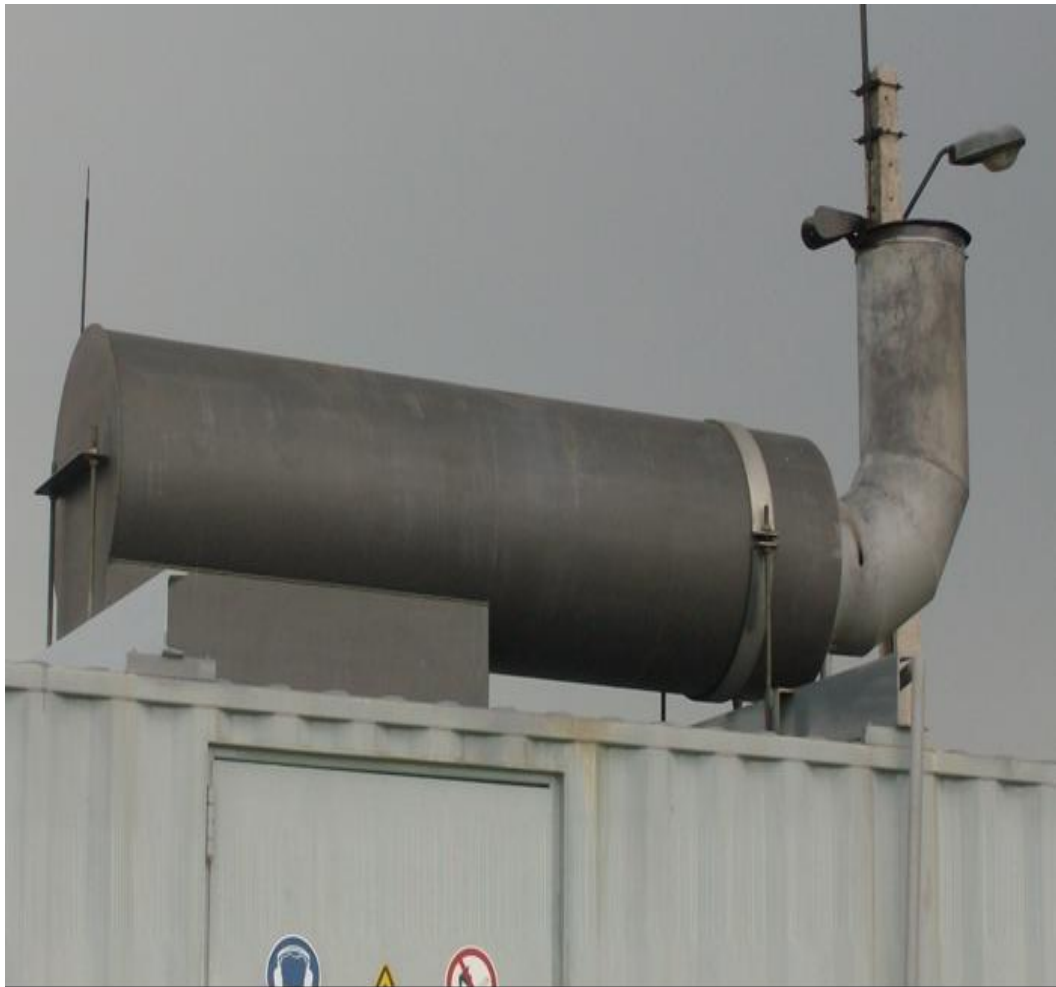
Figura 2.3. Modificación en el conducto final del escape con caperuza.
