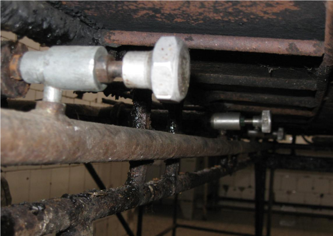
Anexo H: Válvula reguladora del gas licuado.
