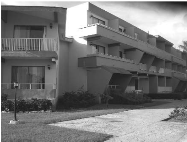
Figura 1. Edificio escogido para la simulación térmica.
