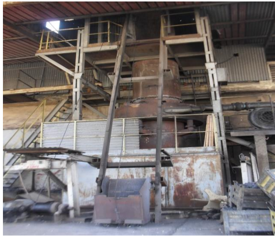
Figura 2.1 Horno de cubilote del taller de fundición de hierro y acero de Holguín.
