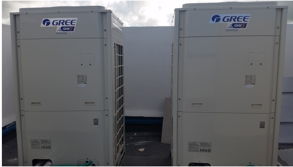
Figura 1.19: Unidades Centralizadas de caudal variable.
