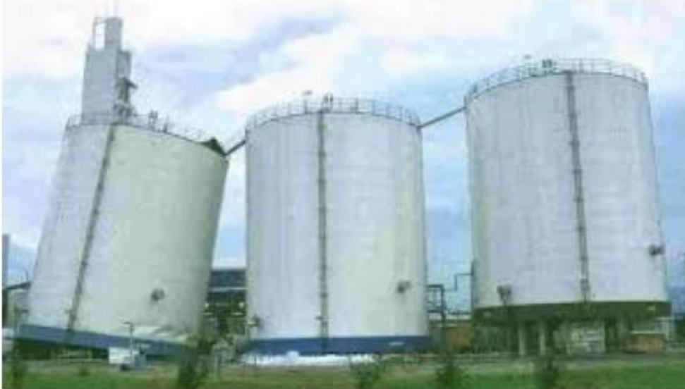
Figura 1.11 Fallo por terremoto. (Fuente: González Dorta, Davinia, 2018)
