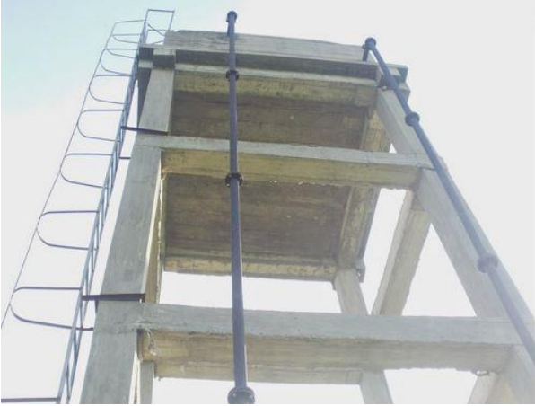
Figura 1.5. Tanque de concreto reforzado. (Fuente: Pérez Arbella, O. 2018)
