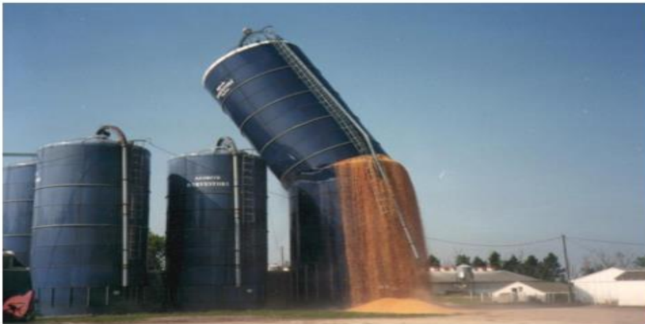
Figura 1.8 Fallo por dimensionamiento incorrecto. (Fuente: González Dorta, Davinia, 2018)
