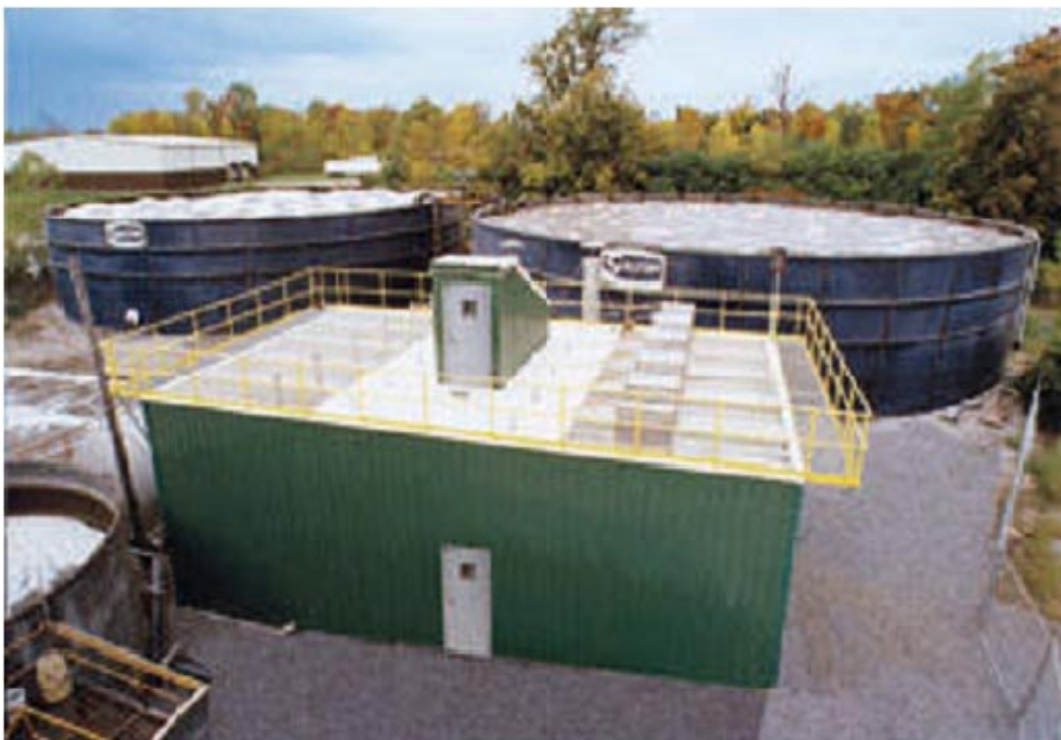
Figura No 1. Planta compacta USAB.
