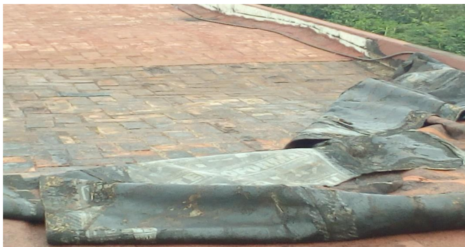
Figura 5: Cubierta del bloque habitacional.
