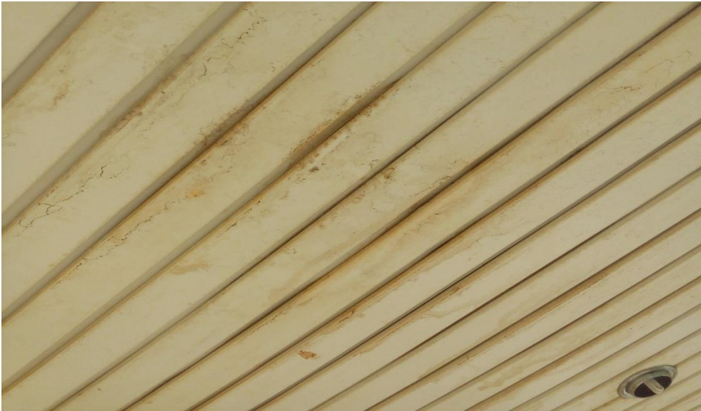
Figura 8: Falso techo de los pasillos.
