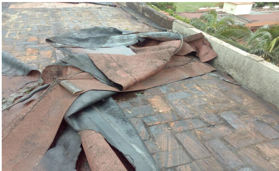
Figura 6: Cubierta del ala izquierda del edificio administrativo.
