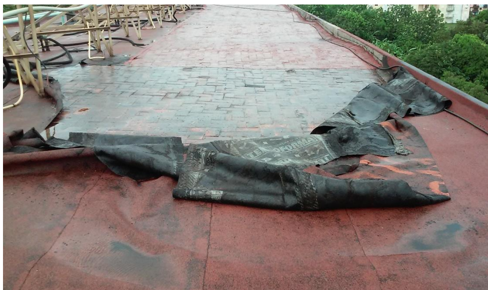
Figura 7: Cubierta de las cabañas.
