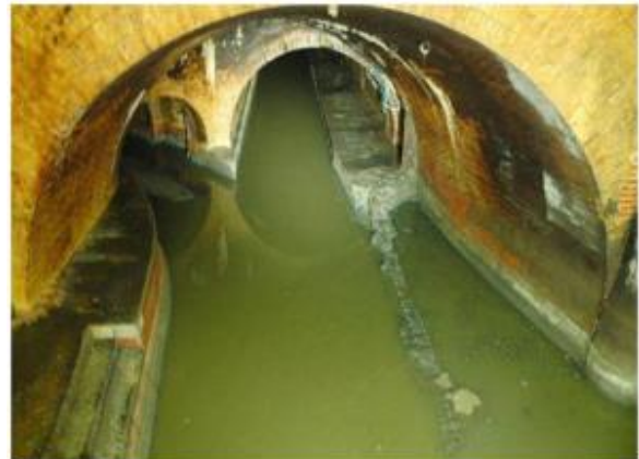
Figuras 3 y 4. Colector principal de aguas residuales en Hamburgo, Berlín, Alemania: Trülzsch, 2015
