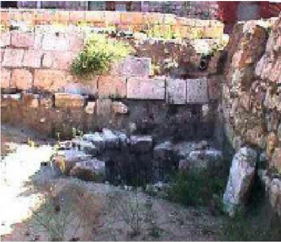
Figura 1. Desagüe y pozo junto a muro perimetral. Rosel Campos Fernando: Libro de la Historia del Saneamiento de Valladolid
