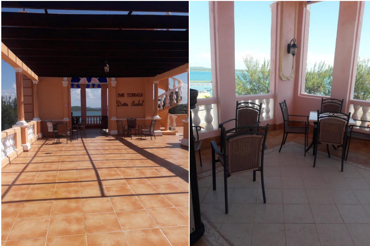
Fig-18: Bar terraza de la cubierta
