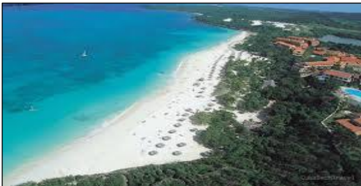
Figura-19: Foto vista aérea del Hotel Sol Club Río de Luna y Mares Resort.
