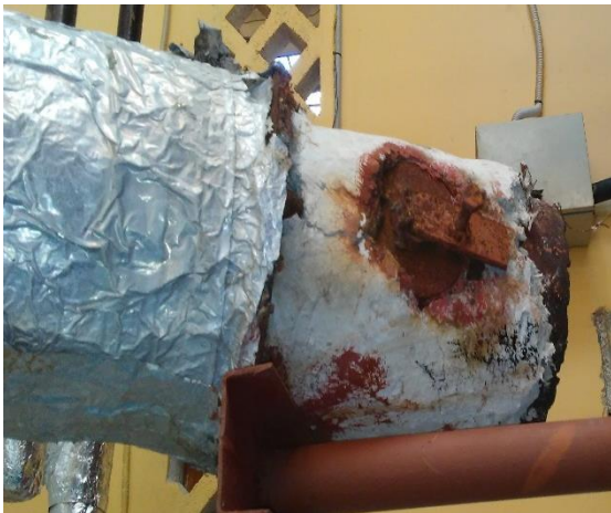
Figura –11: Foto de corrosión atmosférica en sistema de calefacción. Hotel Sol Club Río de Luna y Mares Resort. atmosféricos están presentes.
