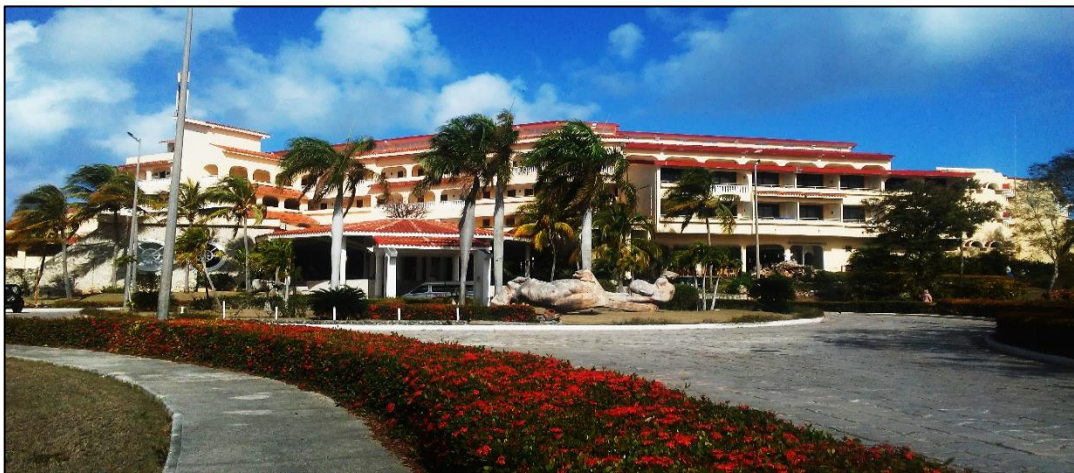
Figura-20: Foto de distribución y disposición físico espacial del Hotel Sol Club Río de y Mares Resort.
