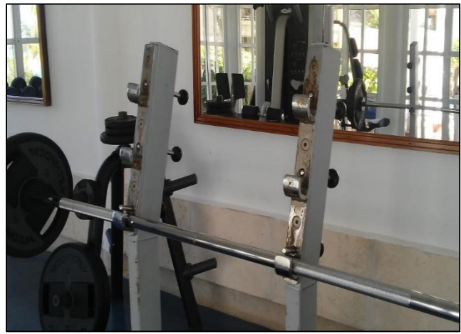
Figura-23: Foto de corrosión en gimnasio masculino Hotel Sol Club Río de Luna Mares Resort
