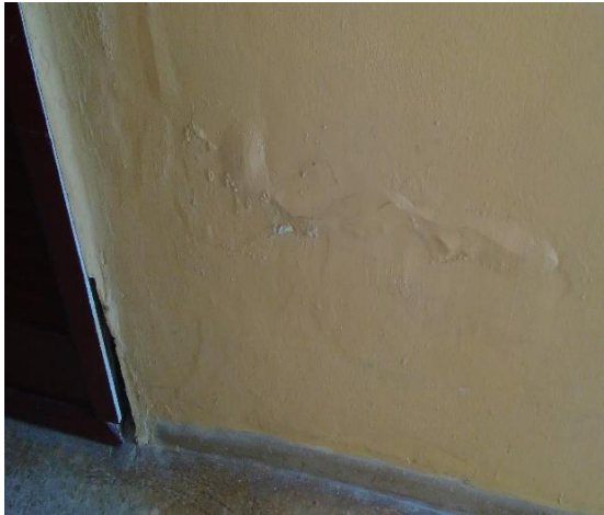
Figura-23: Foto humedad reiterativa en pared. Hotel Sol Club Río de Luna Mares Resort.
