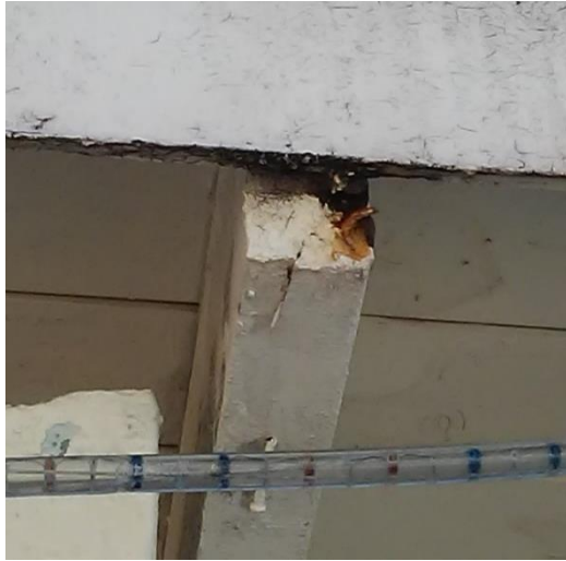
Figura-7: Foto Acero expuesto Hotel Sol Club Rio de Luna y Mares Resort
