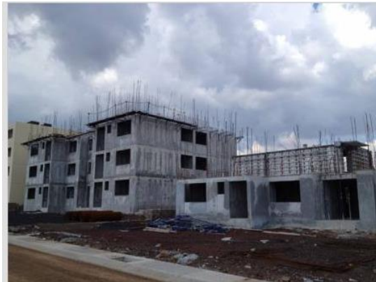
Figura II.1: Edificio multifamiliar que se construye con el sistema FORSA Fuente: http://www.larepublica.co/comercio-externo/m%C3%A1s-de-22-pa%C3%ADses-comprende-el-mercado-internacional-de-forsa_109956
