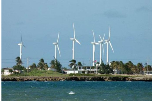
Figura I.5: Parque eólico de Aerogenerador de eje horizontal en Holguín, Cuba Fuente: http://www.energiza.org/eolica/21-eolica/813-en-20-anos-el-mercado-de-la-energia-eolica-mundial-se-multiplicara-por-10
