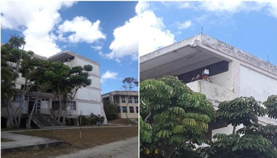
Fig. 2.6. Estacionado #12 (Station 12) realizado desde el edificio de docencia.
