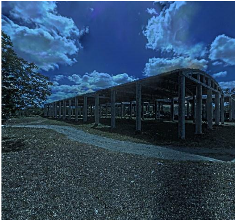
Fig. 2.1. Vista lateral del caso de estudio Naves UHo.
