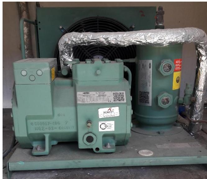
**Figura 2.1.** Unidad condensadora de la cámara de congelación.
