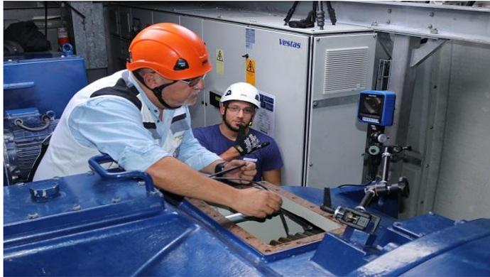
Figura 1.9 Inspección boroscópica en aerogenerador. Fuente: (Garrido, 2018)
